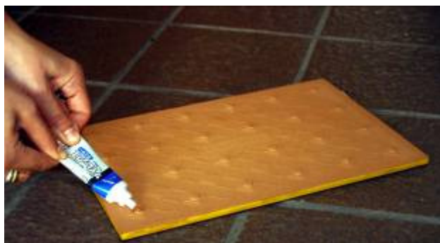
③タイル裏面に接着剤を塗布し、ヘラでのばします。④タイルを強力なガムテープで取り付け面にしっかり固定します。そのまま1日以上放置し、接着剤が乾いたのを確認後、ガムテープを取り外してください。
