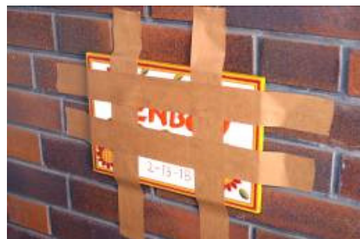
③タイル裏面に接着剤を塗布し、ヘラでのばします。④タイルを強力なガムテープで取り付け面にしっかり固定します。そのまま1日以上放置し、接着剤が乾いたのを確認後、ガムテープを取り外してください。
